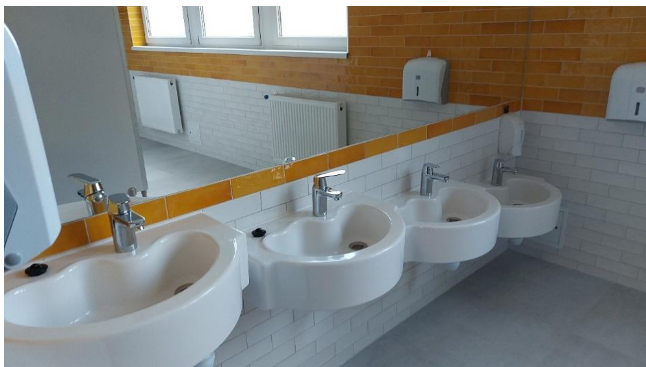
Fot. Widok zrealizowanych prac.
