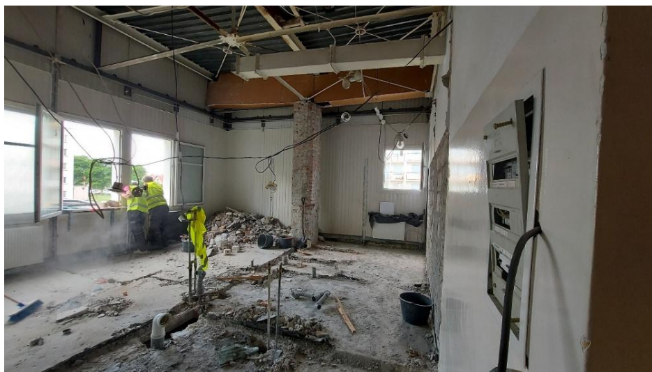
Fot. Widok prowadzonych prac
