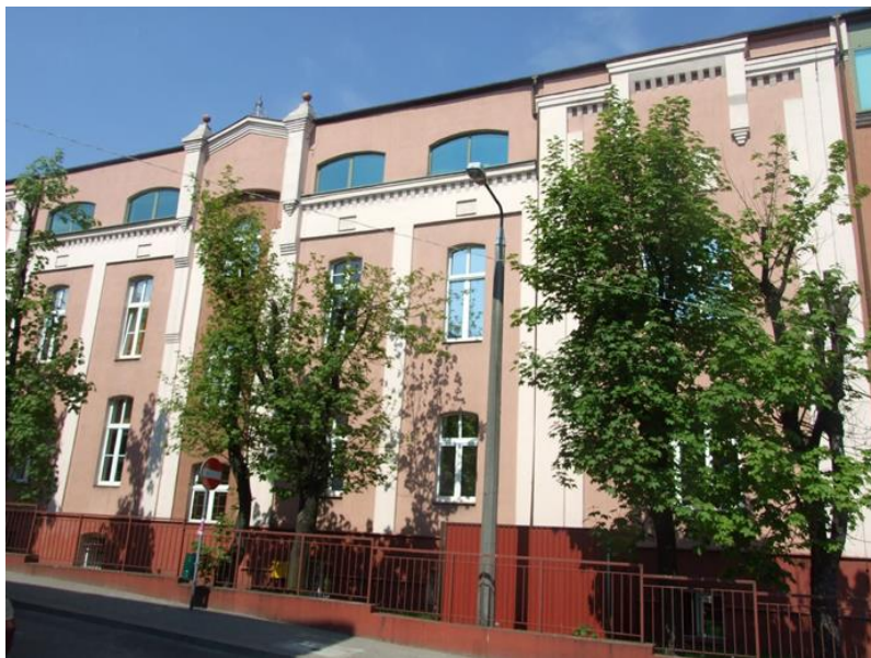
Kamienica – Szpital Powiatowy Sp. z o.o. w Chełmży
