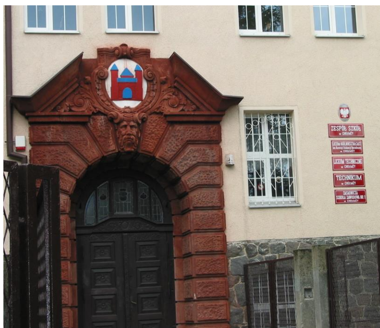
Główne wejście do budynku Zespołu Szkół Ponadpodstawowych obramowane piaskowcem z umieszczonym nad nim motywem antycznym i herbem miasta
